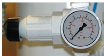
Tryckluftsregulator 3/4" Manometer 0-10 BM
